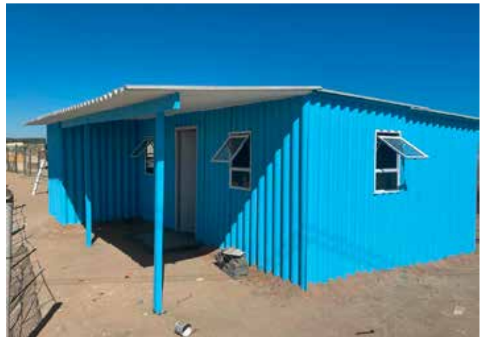
Das Haus verfügt neben den beiden Räumen über eine Außenveranda, die nach außen hin Schatten bietet und im Inneren als ein Badezimmer konzipiert ist, in dem eine Waschwanne mit Schöpfkelle steht und in der ein Spiegel und ein kleines Regal angebracht sind. Wasser zum Kochen und zum Waschen muss an einer öffentlichen Zapfsäule gekauft und in Kanistern zum Haus transportiert werden.
