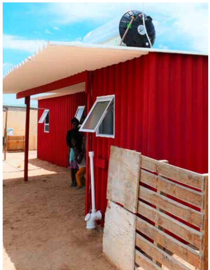
Es gibt einen Warmwasserboiler auf dem Dach
