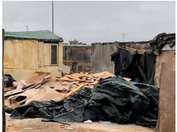
Abriss der alten Unterkunft
