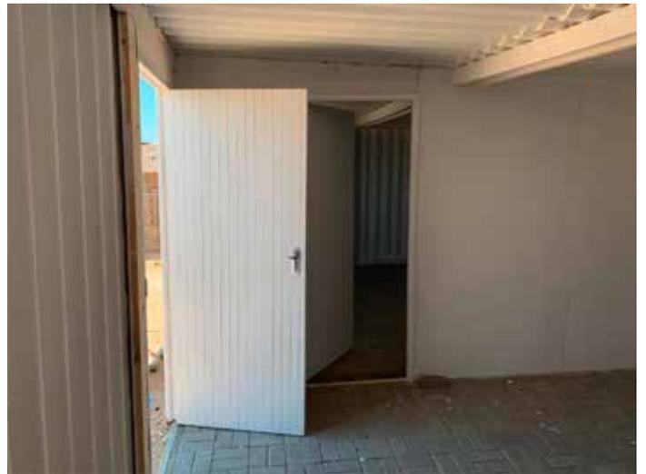
Der Boden wurde begradigt und mit Zementsteinen verlegt. (Die Behausungen im Township haben im Regelfall gar keinen Boden.) Dann folgte der Innenanstrich.
