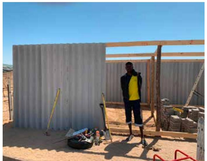
*Das Haus wurde aus einem Holzgerüst und Faserzementplatten errichtet. Das ist eine günstige Art zu bauen. Trotzdem ist das Material im Vergleich zum gängigen Wellblech dicker und schafft eine bessere Isolation gegen Hitze, Kälte und Sandstürme.*
